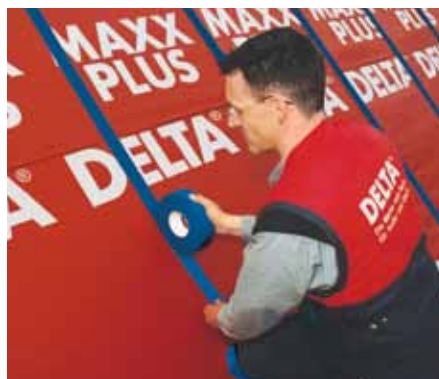
Уплотнение контробрешётки DELTA®-SB 60
