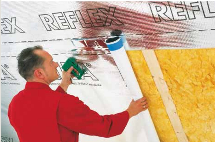
Пароизоляционная плёнка DELTA®-REFLEX PLUS со встроенной самоклеящейся лентой и теплоотражающим слоем.
