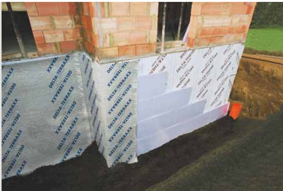
Дренажная мембрана DELTA®-TERRAXX и гидроизоляция DELTA®-THAN.
