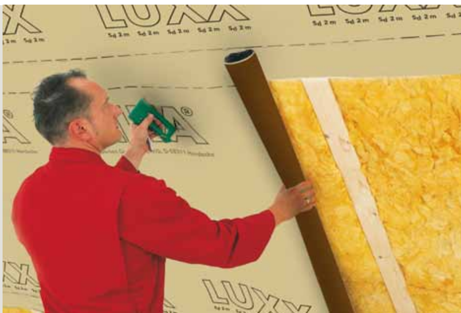
Пароизоляция DELTA®-LUXX с «дышащим эффектом» для деревянных домов.
