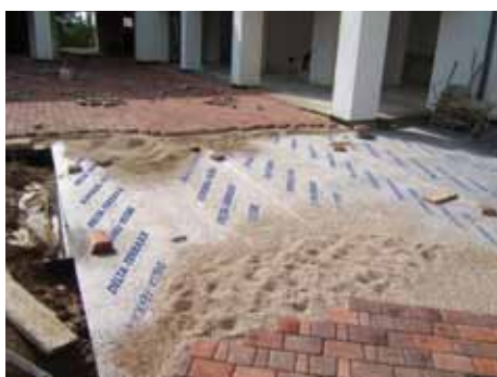
Конструкция зелёной крыши с DELTA®-FLORAXX TOP.
