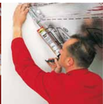
Пароизоляционная плёнка DELTA®-REFLEX PLUS со встроенной самоклеящейся лентой и теплоотражающим слоем.
