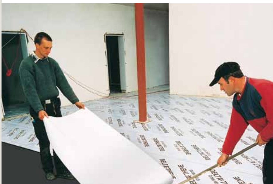
Гидроизоляция пола коттеджа мембраной DELTA®-THAN.
