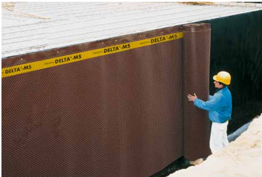
Защита битумной гидроизоляции коттеджа мембраной DELTA®-MS.
