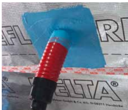
Уплотнение проходки DELTA®-LIQUIXX
