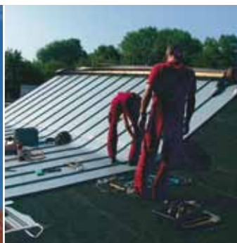
Гидроизоляционная плёнка DELTA®-FOL PVG в качестве разделительного слоя под медную кровлю.
