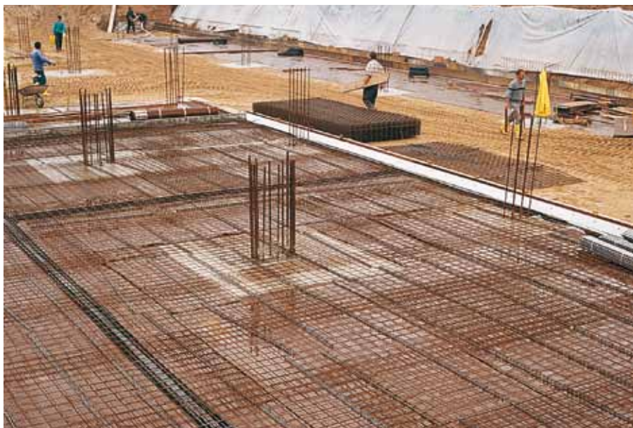
Замена бетонной подготовки с DELTA®-MS.
