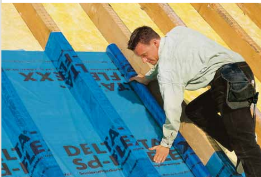
Пароизоляционная плёнка DELTA®-Sd-FLEXX для ремонта мансарды с внешней стороны.
