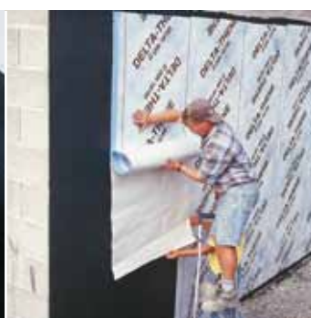
Гидроизоляция пола коттеджа мембраной DELTA®-THAN.
