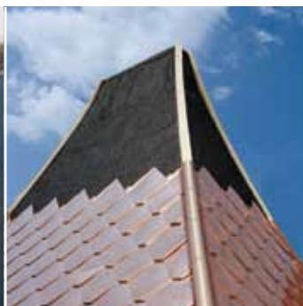
Гидроизоляционная плёнка DELTA®-FOL PVG в качестве разделительного слоя под медную кровлю.
